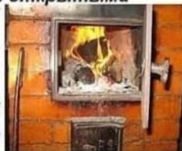
Размер дров должен соответствовать размерам топливника
