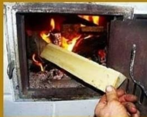
Размер дров должен соответствовать размерам топливника
